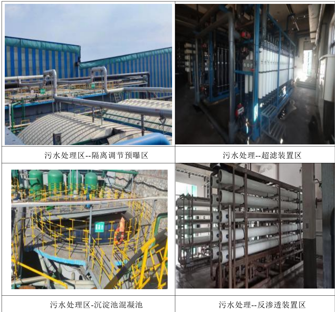
图4-8 污水处理站踏勘现状
